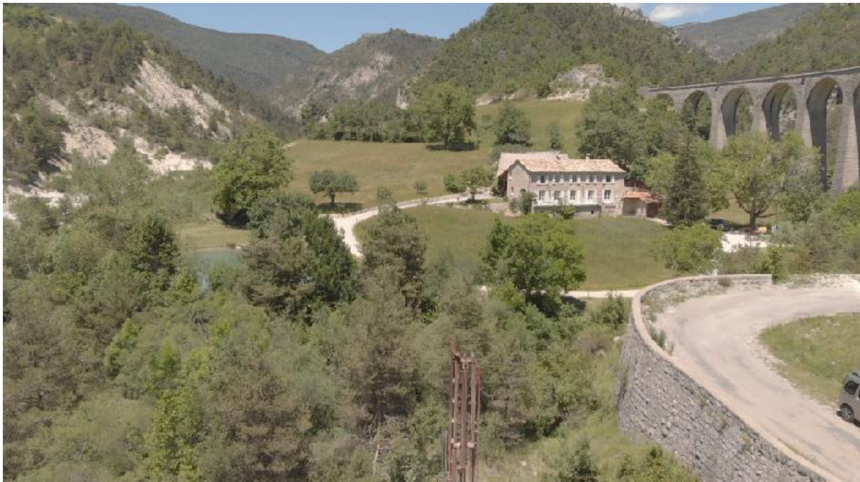
Environnement rapproché du forage
